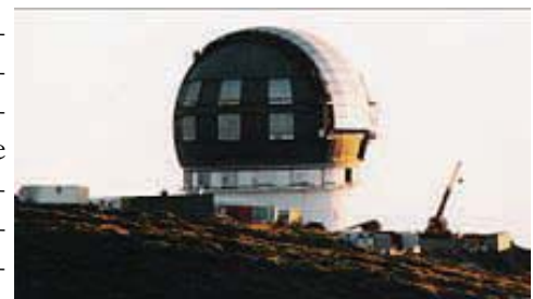
Gran Telescopio Canarias en construcción, 2002.
